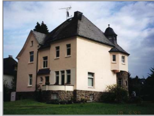
Wahlscheiderstr. 32, in Wahlscheidt Planung- Ausschreibung – Bauleitung Fassadeninstandsetzung , 1998
