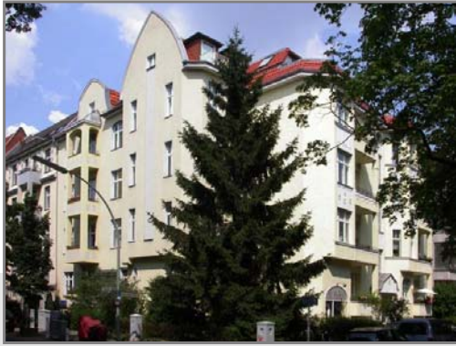
Laubacherstr. 19a, in Berlin Friedenau Planung- Ausschreibung – Bauleitung Fassadeninstandsetzung, 1997
