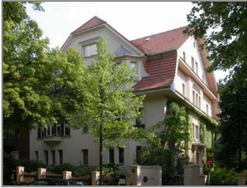
Lyckallee 16, in Berlin Westend Planung- Ausschreibung – Bauleitung Dach- u. Fassadeninstandsetzung, 2003
