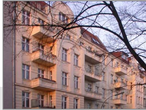
Weichselplatz 5/6, in Berlin Neukölln Planung- Ausschreibung – Bauleitung Fassaden- u. Terrasseninstandsetzung, 2004
