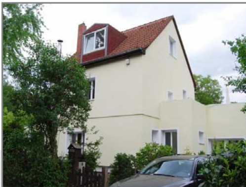
Schwarzdornweg 7, in Berlin Lichterfelde Planung- Ausschreibung – Bauleitung Energetische Modernisierung, 2008
