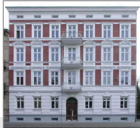
Zeppelinstr. 150, in Potsdam Planung- Ausschreibung – Bauleitung Modernisierung des gesamten Gebäudes 2006/2007
