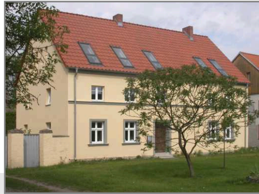
Parkstr. 12, in Gottsdorf Planung – Ausschreibung - Bauleitung Dachgeschoßausbau und Modernisierung eines Einfamilienhauses, 2004/5
