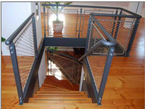
Parkstr. 12, in Gottsdorf Treppe zum DG
